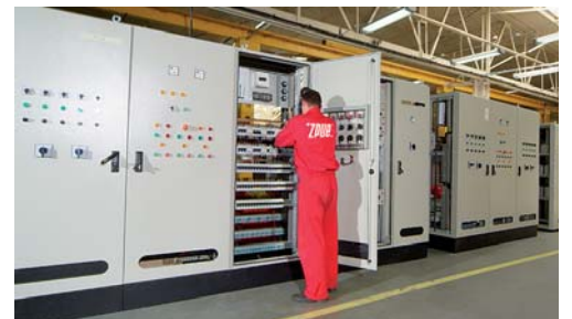
Электротехнический отдел – установка распределительных устройств
